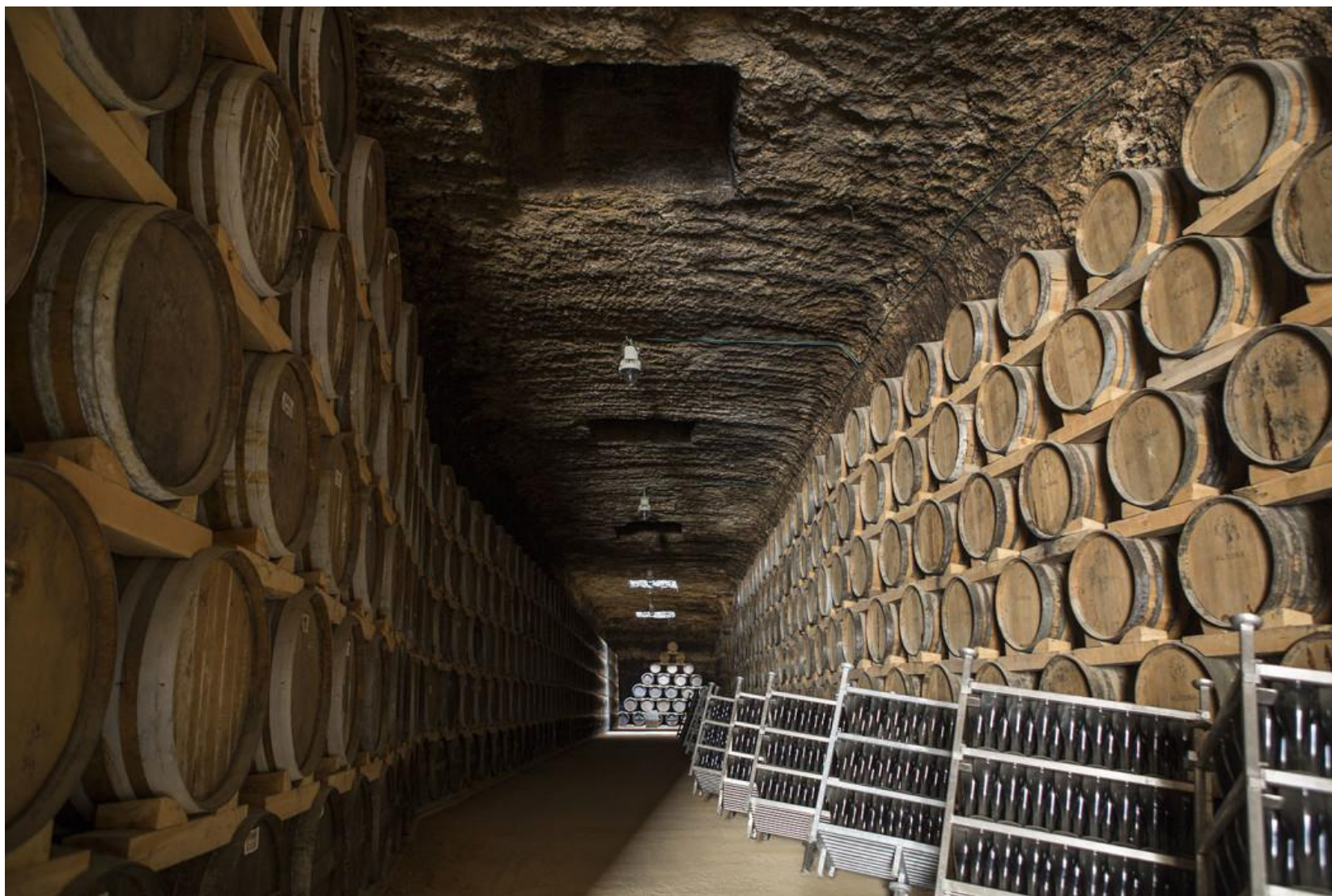
Verum酒庄地下酒窖：>8000平方米，3米厚、10米深，无人工支柱
